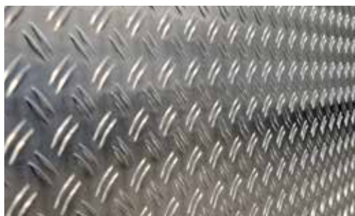
Plancher recouvert d'une tôle en aluminium striée
