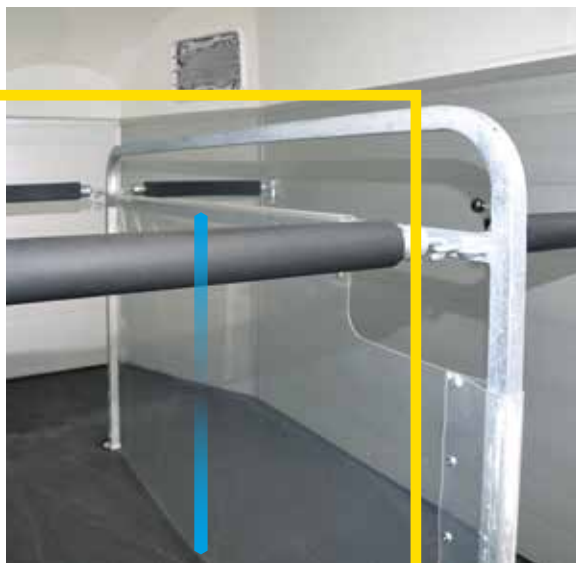
22 Bat-flanc continu jusqu'au plancher
